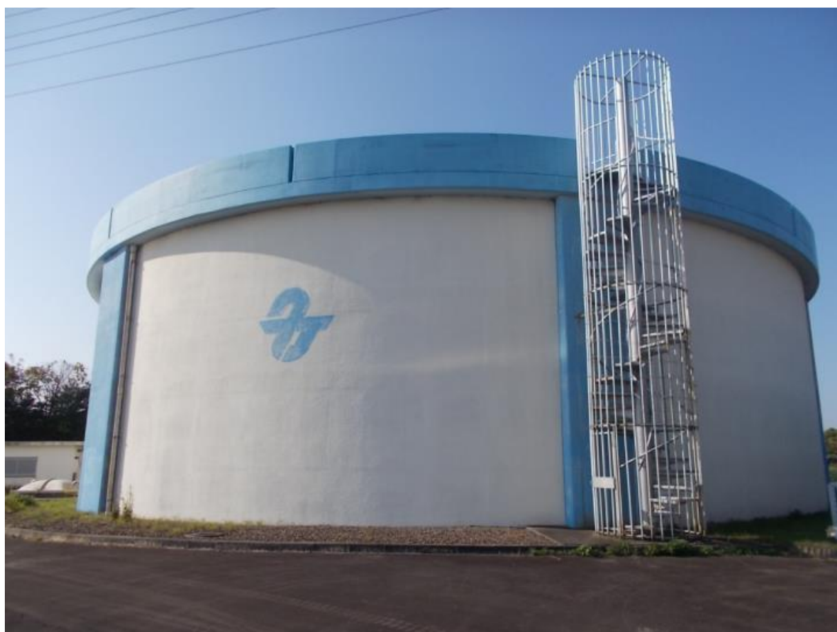
武豊第2配水池
